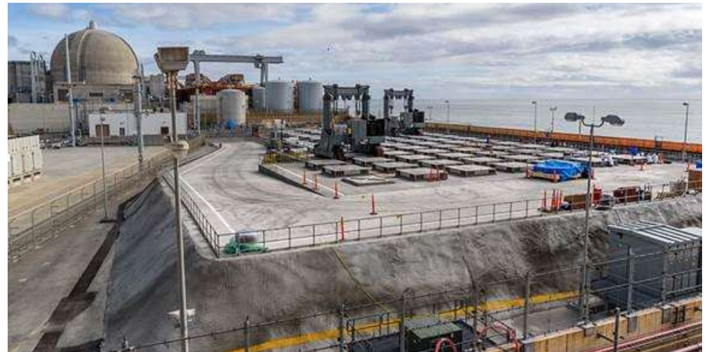
Holtec社 HI-STORM UMAX サンオノフレ原子力発電所
