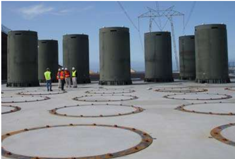
Holtec社 アンカー固定方式HI-STORM ディアボロキャニオン原子力発電所
