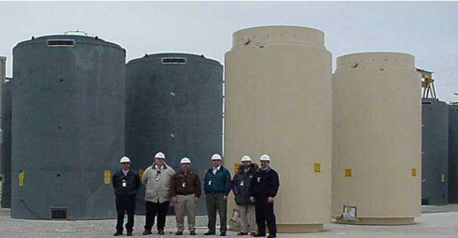
ドレスデン原子力発電所
