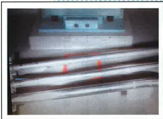
確認ポイントに赤マーキング実施
