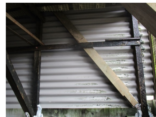
End Bent(西側/南)
