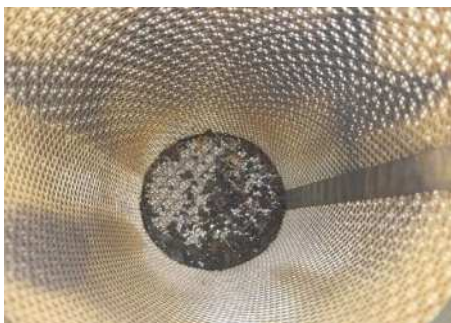
<N 2 バブリング後のSGブローダウン系統の仮設ストレーナ×回収スラッジの拡大図>
