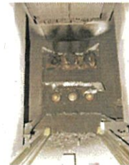
盤内開口部の状態(遮断器室)
