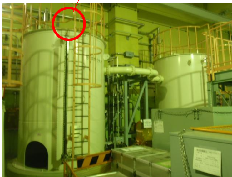
図 2-3 現場確認結果 (例) B-原子炉補機冷却系サージタンク ベント管設置箇所
