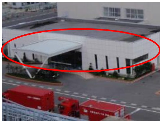
114 出入管理棟南側ガラス窓
