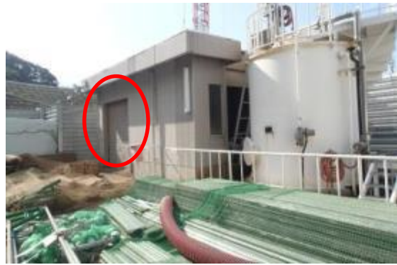
99 鉄イオン貯蔵建物南側シャッター
