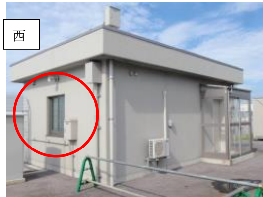
148 北口建物西側ガラス窓
