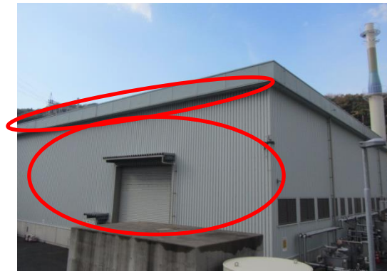
165 3号炉補助ボイラ
