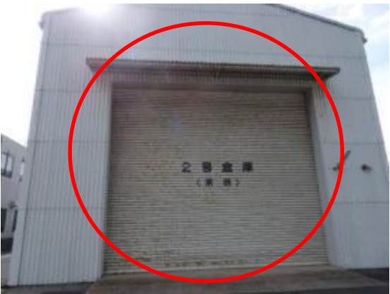
63 2号倉庫東側シャッター
