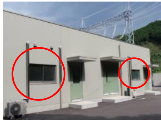
123 固体廃棄物貯蔵所D棟付属建物西側ガラス窓
