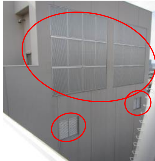
30 T/B空調換気系給気用格子
