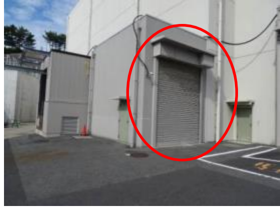
66 サイトパンカ建物南側シャッター
