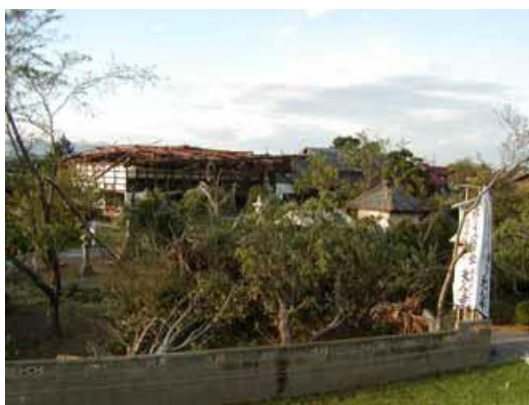
写真1 天神寺外観(南から見る)
