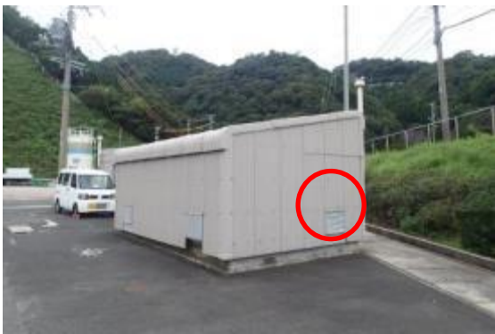
108 危険物屋内貯蔵倉庫給気用格子
