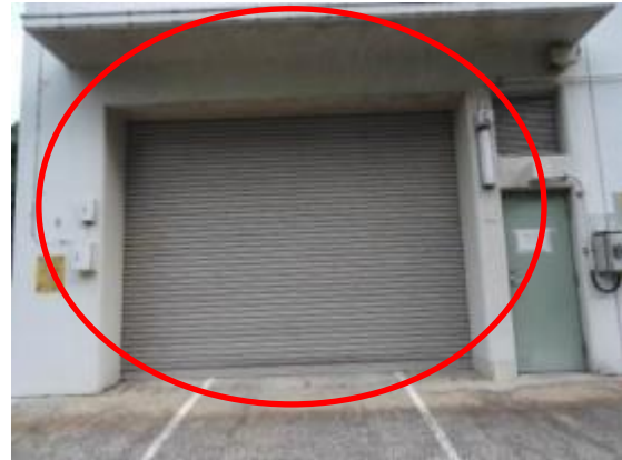
86 固体廃棄物貯蔵庫B棟南西側シャッター（1）
