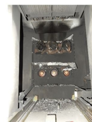
盤内開口部の状態(遮断器室)
