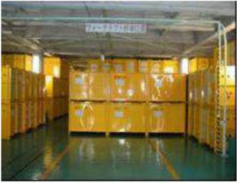
貯蔵室 (A001)<br>(床 T. P. 約+1.4m)<br>貯蔵室 (A101)<br>(床 T. P. 約+6.2m)<br>貯蔵室 (G201)<br>(床 T. P. 約+11.2m)<br>コンテナを最大 3 段積みにして貯蔵。 |                          |
