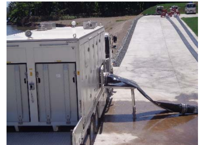
可搬型建屋外ホース接続 (300A)
