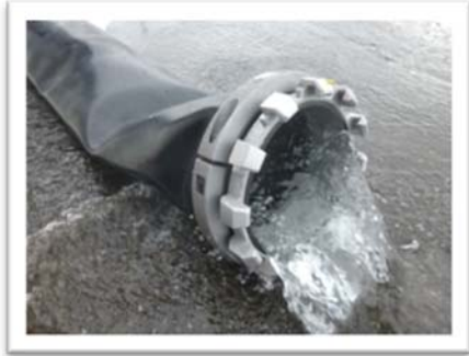
建屋外ホース接続箇所 (300A)
