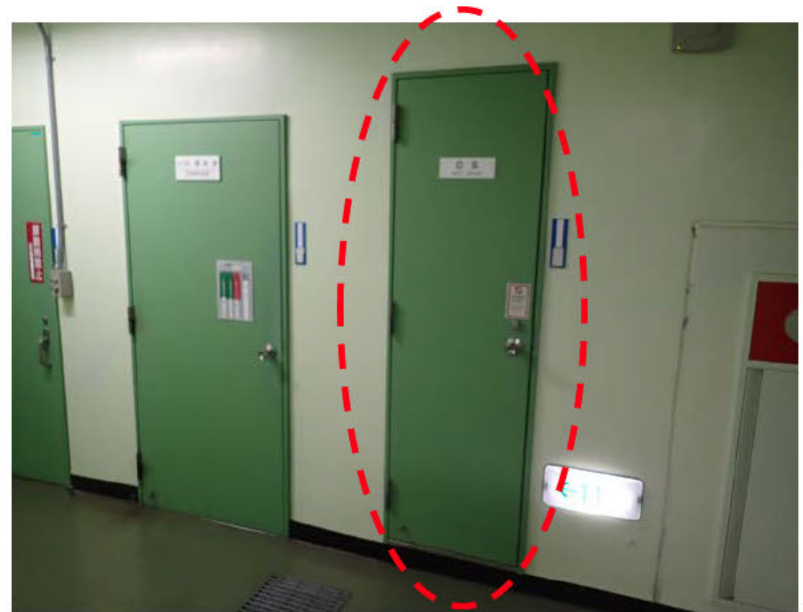
図 ダクトスペース外観
