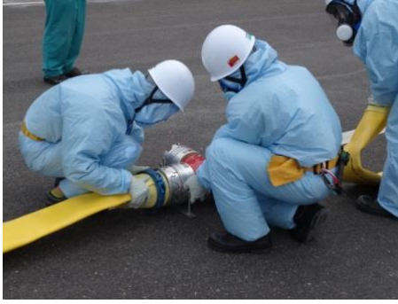
ホース接続作業（昼間）
