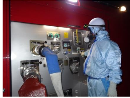
ポンプ起動操作（夜間）
