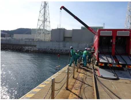
水中ポンプ設置の状況
