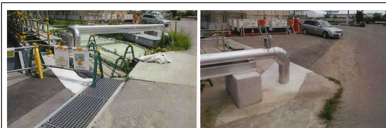
消火配管設置場所の写真
