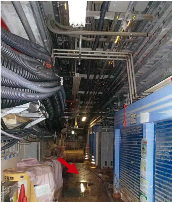
写真1：タービン建屋通路
