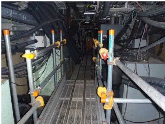
写真2：堰設置予定箇所
