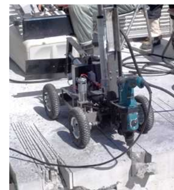
はつりロボット(モックアップ機)
