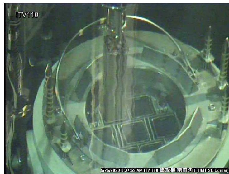
使用済燃料の輸送容器への装填状況
