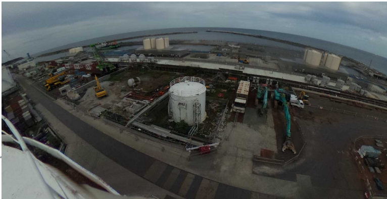
L型防潮堤施工前(2019年9月20日撮影)
