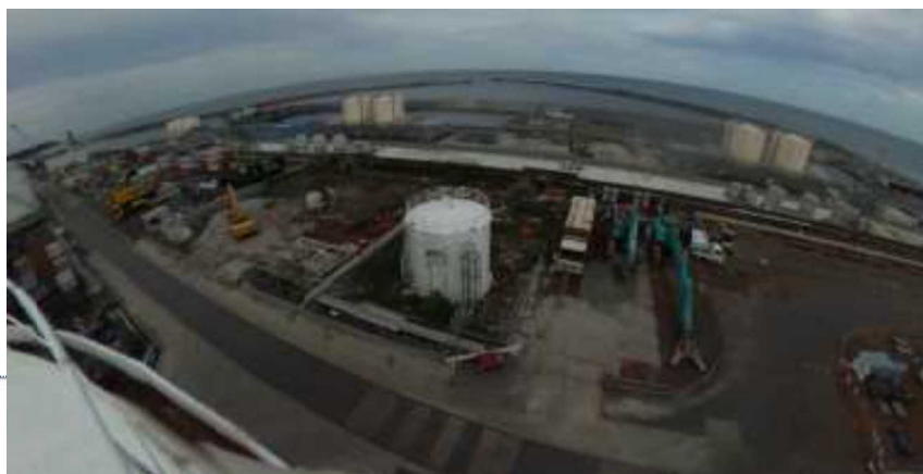
L型防潮堤施工前(2019年9月20日撮影)
