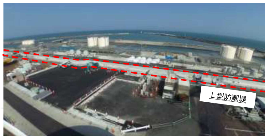
L型防潮堤施工後(2020年4月4日撮影)
