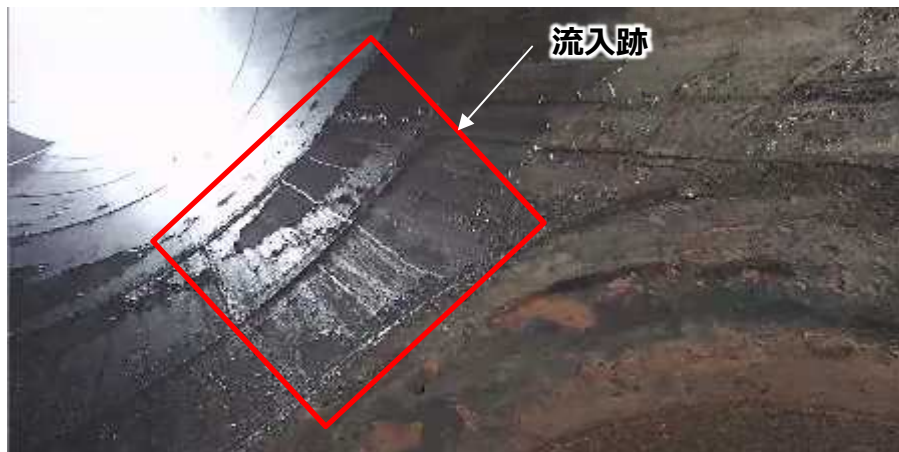
写真：排気筒内面状況(5/20雨天時)
