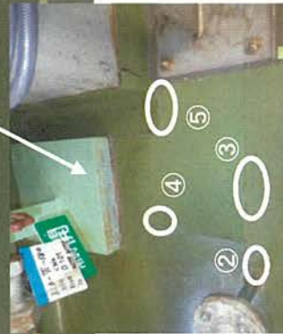
床貫通配管とコンクリートの間 のすき間の状況(一例) ①～⑤:ビニール製床シートどうしの溶着が剥がれ、 コンクリートとの接着が剥がれている部分を確認
