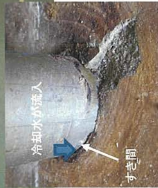
床貫通配管とコンクリートの間 のすき間の状況(一例) ①～⑤:ビニール製床シートどうしの溶着が剥がれ、 コンクリートとの接着が剥がれている部分を確認
