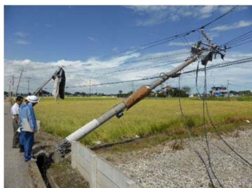
電柱の倒壊
