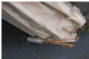
飛散した折板屋根の損傷状況
