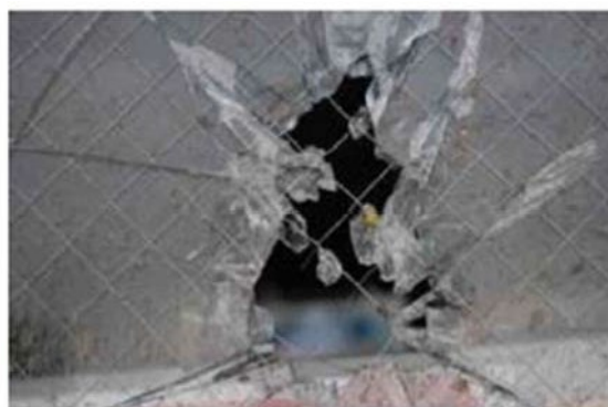
店舗の窓ガラスの被害状況（飛来物衝突痕）
