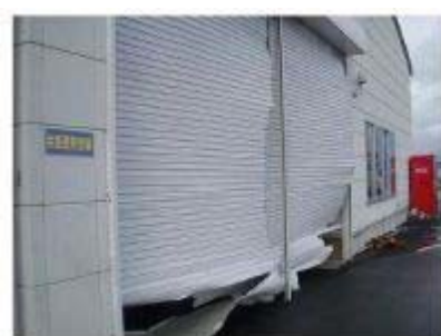
図1.1-2 平成21年10月8日茨城県土浦市で発生した F 1 竜巻によるシャッターの被害状況 (2)
