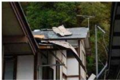
飛来物（鋼板製屋根材）の衝突
