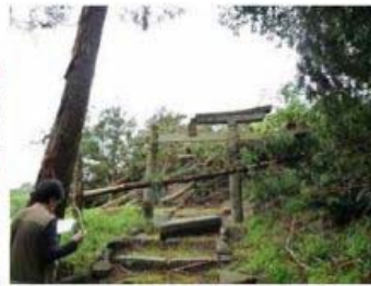
樹木の折損と鳥居の被害
