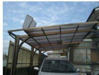
カーポート屋根の損傷
