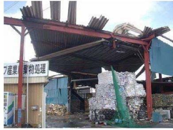
折板の損傷
