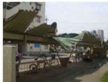
駐車場の折板屋根の著しい変形
