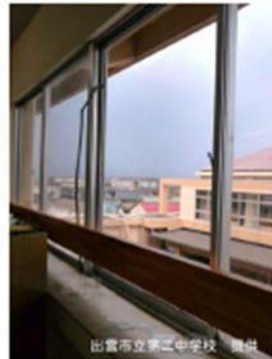
屋外に面した窓ガラス
