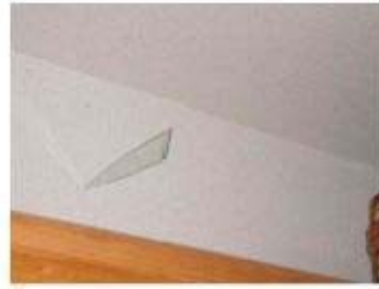
エントランスの窓ガラスの損壊 破損した窓ガラス片の屋内壁面への突き刺さり
