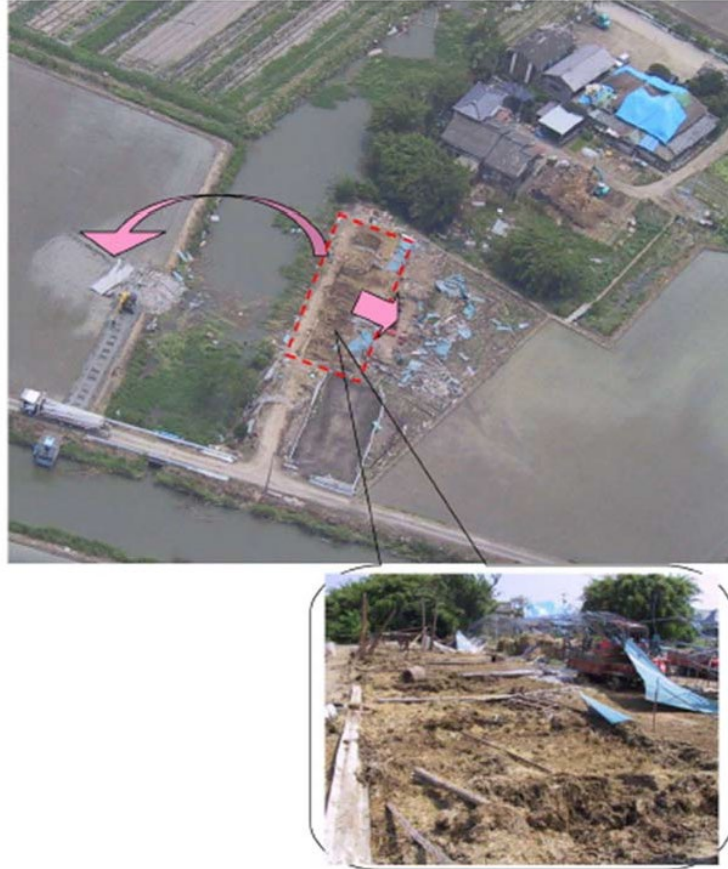
図2.1-1 平成16年6月27日佐賀県で発生したF2竜巻による屋外屋根の被害状況 (9)
