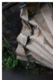
飛散した折板屋根の損傷状況
