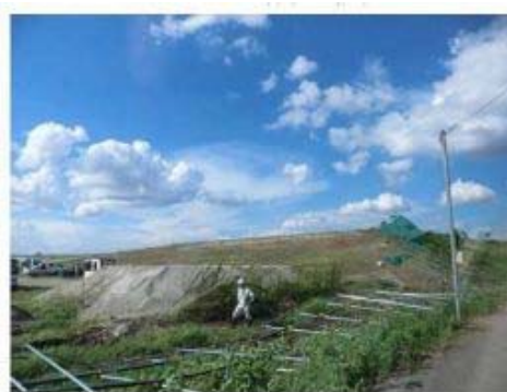
フェンスの倒壊
