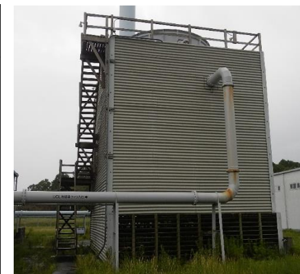
UCL系統冷却塔の外観写真
