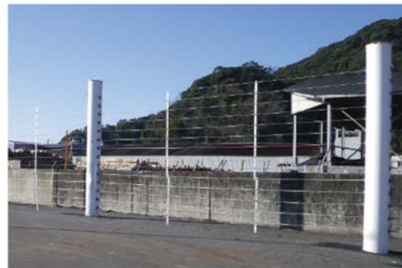
津波漂流物捕捉施設
