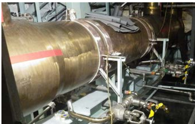
解体前マニホールド(保温材撤去後)
