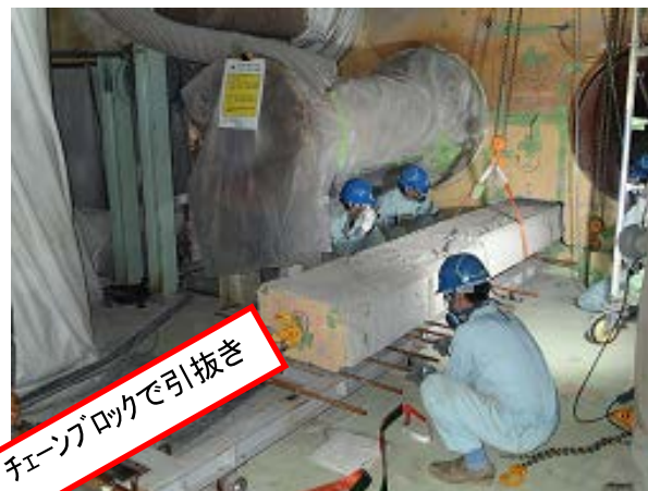
乾式ワイヤーソー切断後の コンクリートブロック引抜き作業
