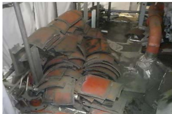
ダクト解体状況(容器収納前)
