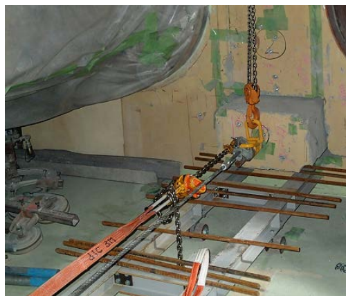
コンクリートブロック引抜きのためのコア 引き架台等の配置
