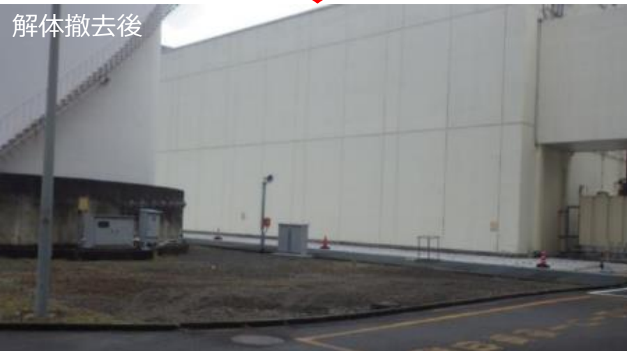
液体炭酸ガス貯槽等の解体状況
