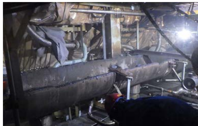
マニホールド 上半分まで解体した状況
