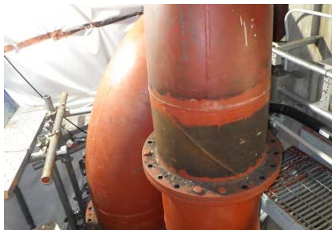
解体前ダクト(保温材撤去後)
