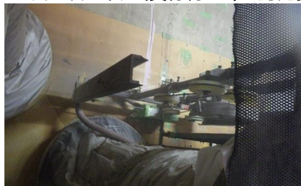
乾式ワイヤーソーによる コンクリート切断作業
