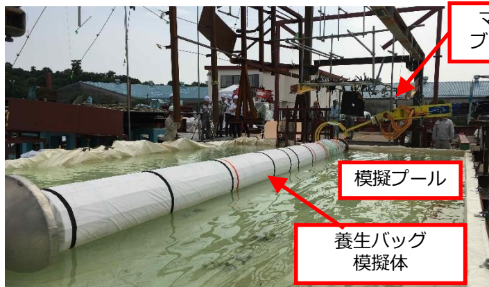
養生バッグを南側に寄せる状況
