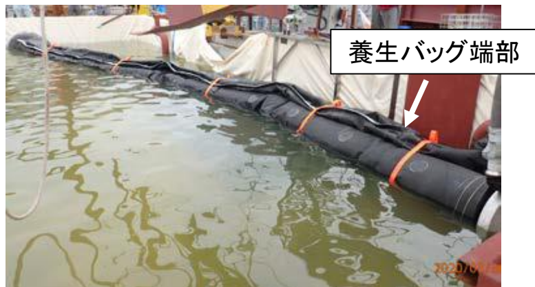
養生バッグ投入完了後の状況
