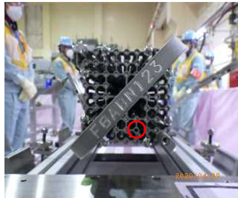
上部タイプレートの取り付け
