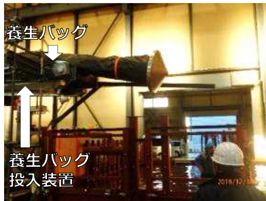
①養生バッグ投入
