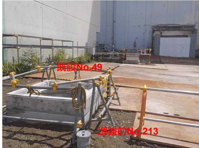
No.49ピット周辺
