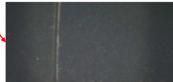
H2-G1タンク内面写真（底板）
