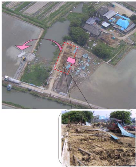
第5-4-1図 平成16年6月27日佐賀県で発生した F2竜巻による屋外屋根の被害状況 (1)
