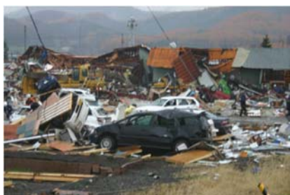
全壊した工事事務所周辺
