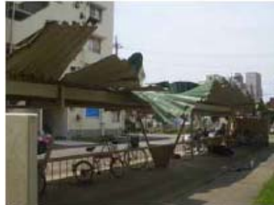
駐車場の折板屋根の著しい変形
