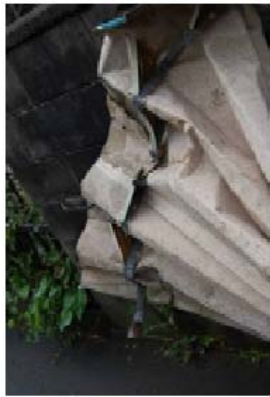
飛散した折板屋根の損傷状況
