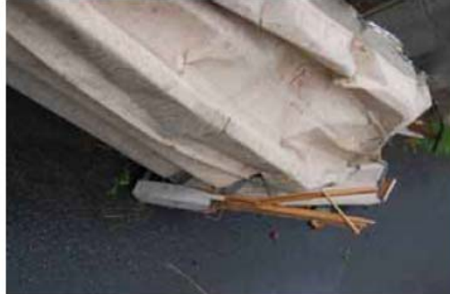
飛散した折板屋根の損傷状況
