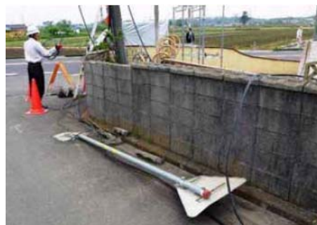
道路標識の倒壊
