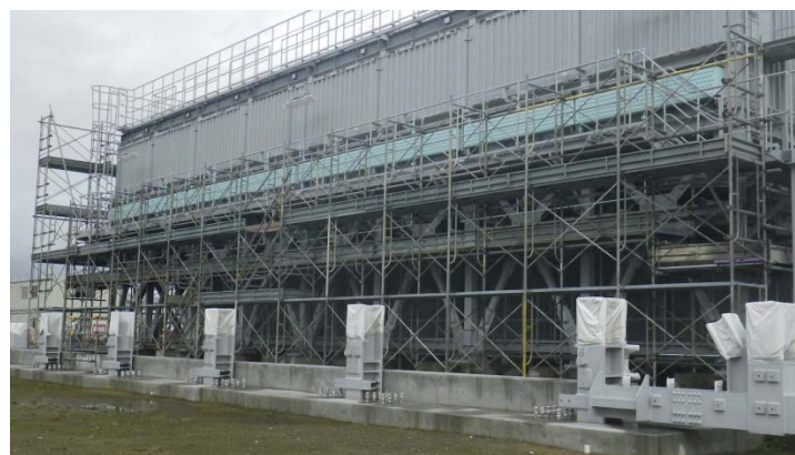
第5-4-33図 再処理事業所内における仮設足場の状況
