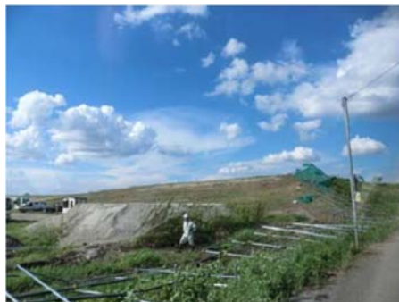
フェンスの倒壊
