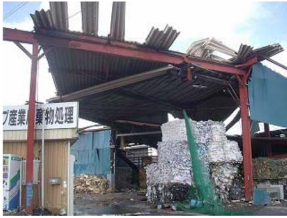
折板の損傷
