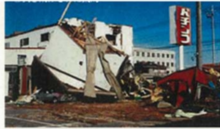
吹き飛ばされた建物
