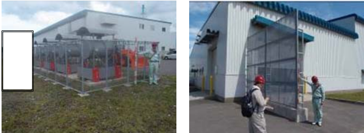
第5-4-32図 再処理事業所内におけるフェンスの状況
