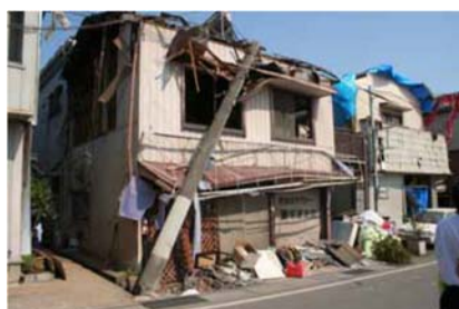
倒壊電柱に直撃された家屋
