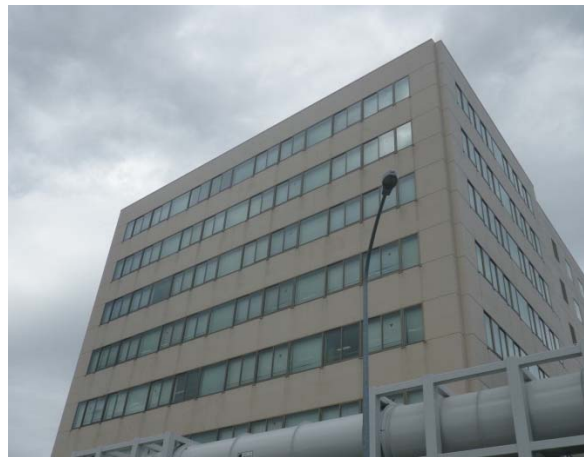
第5-4-13図 再処理事業所内におけるガラス窓の状況
