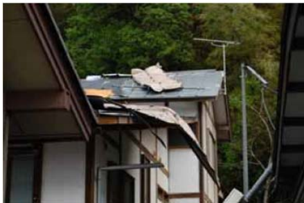
飛来物（鋼板製屋根材）の衝突 飛散した飛来物（鋼板製屋根材）
