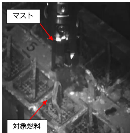
マストとキャスク洗浄装置配管干渉により吊ることができない燃料 (⑭)
