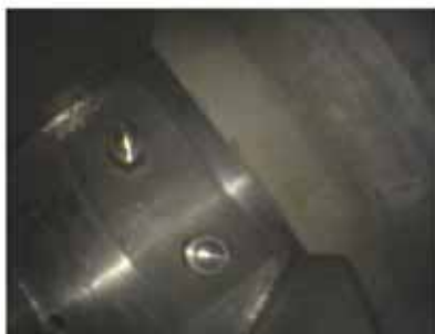
272V36（予備貯槽）の状況 （非放射線環境）
