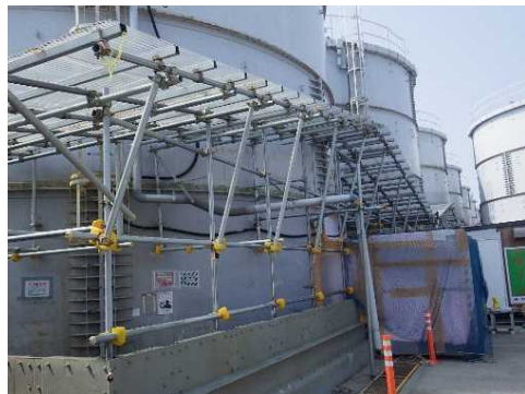
【チェンジングプレース設置状況※1】 1段目マンホールより内部へ浸入
