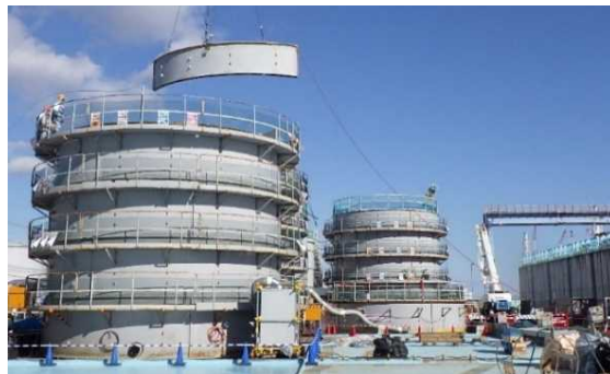
【4段目撤去状況】 天板～2段目を撤去
