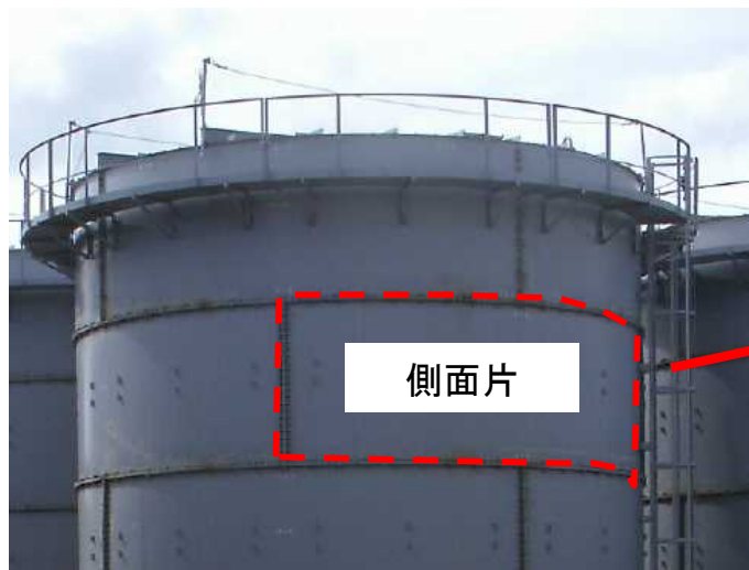
鋼製円筒形フランジ接合タンク
