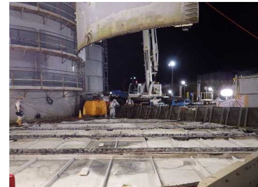
【1段目撤去状況】 1段目・底板を撤去
