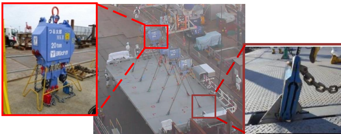
自動玉外し作業状況写真(1号機構台設置工事より)
