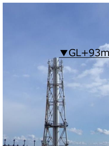
11ブロック解体後 (2020年2月4日)
