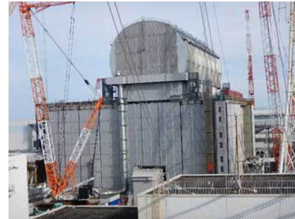
3号機原子炉建屋外観写真の例
