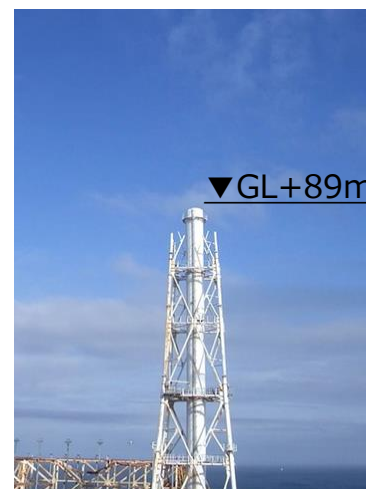
12ブロック解体後 (2020年3月9日)
