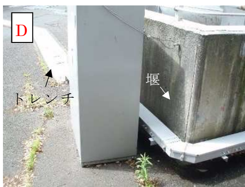
図 8 堰周りの状況 (1号ヒドラジン原液タンク)
