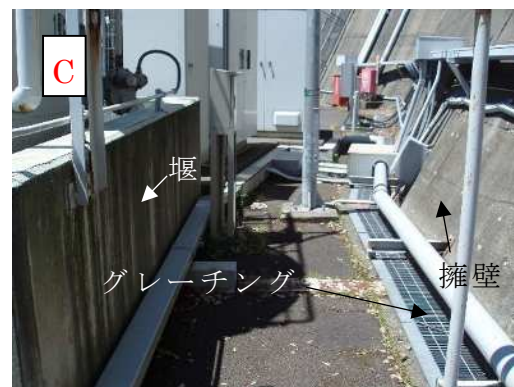
図 8 堰周りの状況 (1号ヒドラジン原液タンク)
