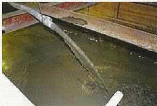
図 5.14.6-7 流動化処理土打設状況
