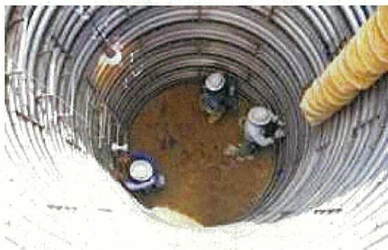
図 5.14.6-3 ライナープレート施工状況
