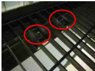
【グレーチング】 金具固定による落下防止処置を確認
