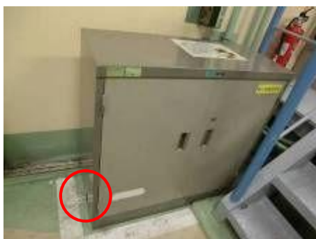
固化建屋17m金属ロッカー固定状況
