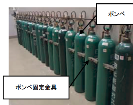
【3号炉タービン建屋 (発電機ポンベ庫)】
