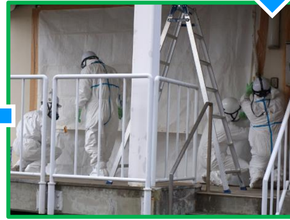
破損した扉を養生する工務班員
