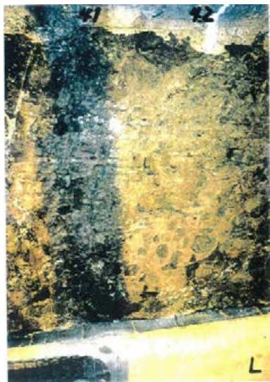
底盤(南側)No.41~42 写真
