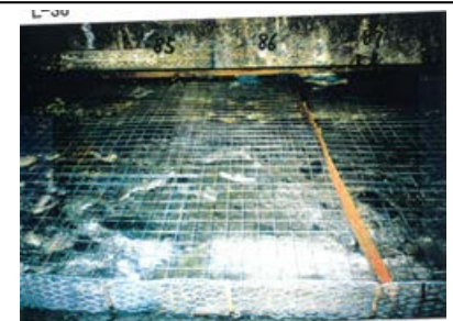
底盤(南側)No.85~87 写真
