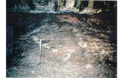
底盤(北側)No.166~168 写真
