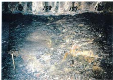
底盤(北側)No.156~159 写真
