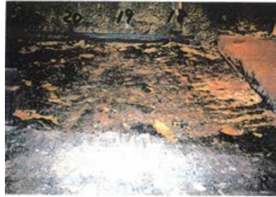
底盤(北側)No.17~20 写真
