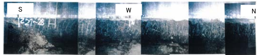
側壁No.28 写真
