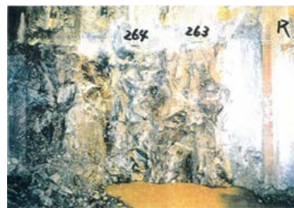
側壁(下半北側)No.263~264 写真
