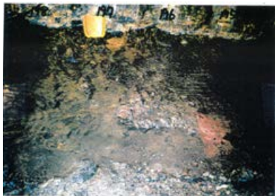
底盤(北側)No.195~198 写真
