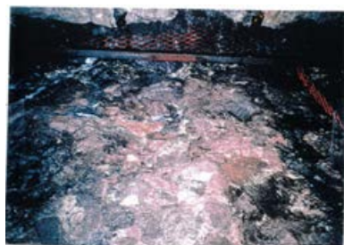
底盤(南側)No.6~7 写真
