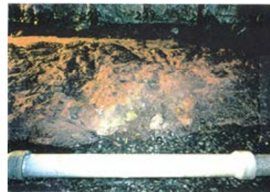
底盤(南側)No.277~280 写真
