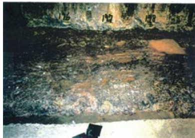
底盤(南側)No.196~198 写真
