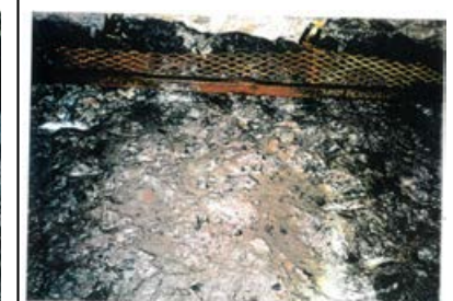
底盤(南側)No.10~11 写真
