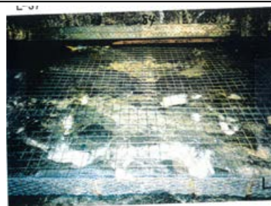
底盤(南側)No.83~85 写真
