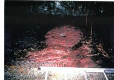
底盤(南側)No.170~171 写真
