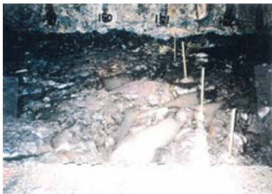
底盤(南側)No.149~152 写真
