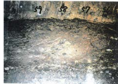
底盤(北側)No.56~59 写真
