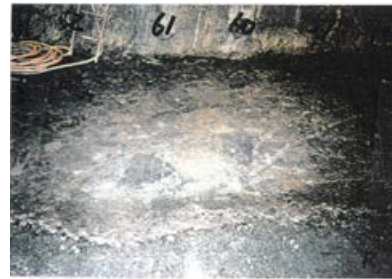
底盤(北側)No.60~62 写真
