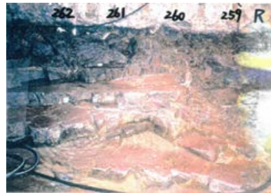
底盤(北側)No.259~262 写真
