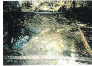
底盤(北側)No.110~112 写真
