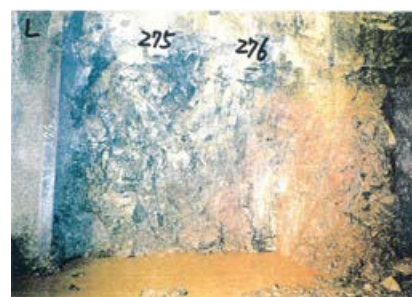
側壁(下半南側)No.275~276 写真
