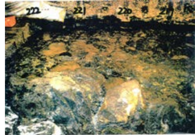
底盤(北側)No.219~222 写真
