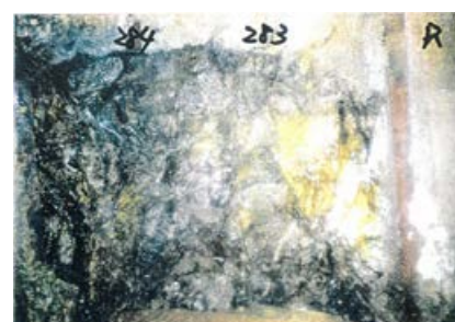
側壁(下半北側)No.283~284 写真
