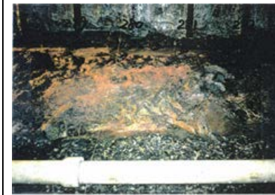
底盤(南側)No.279~282 写真
