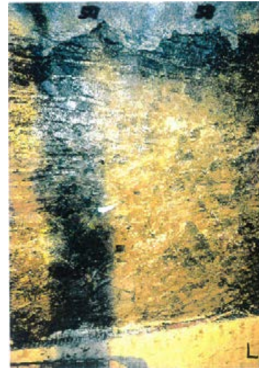
底盤(南側)No.57~58 写真
