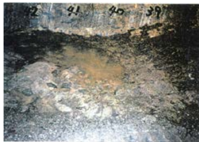
底盤(北側)No.39~42 写真
