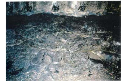
底盤(北側)No.154~157 写真
