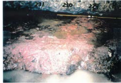
底盤(北側)No.229~231 写真
