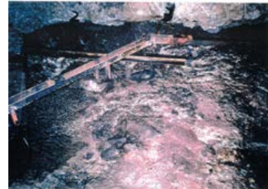
底盤(南側)No.2~3 写真
