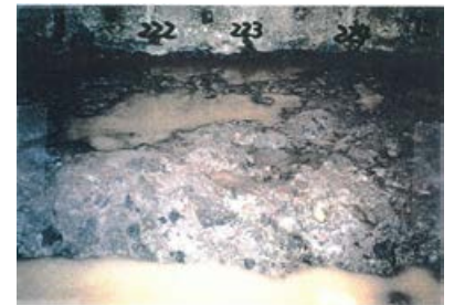
底盤(南側)No.222~224 写真
