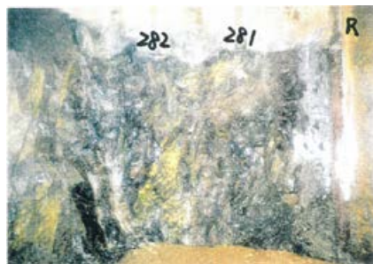
側壁(下半北側)No.281~282 写真
