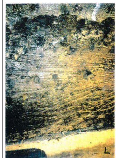
底盤(南側)No.49~51 写真
