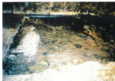
底盤(南側)No.111~114 写真
