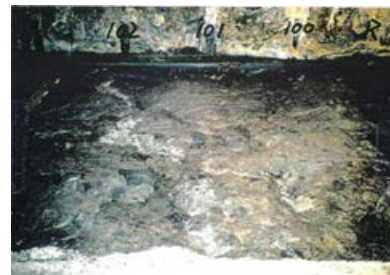
底盤(北側)No.100~102 写真
