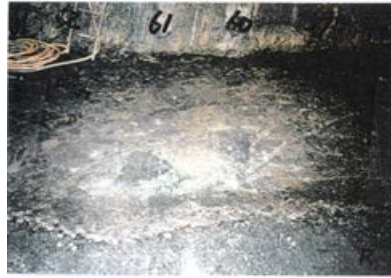
底盤(北側)No.60~61 写真
