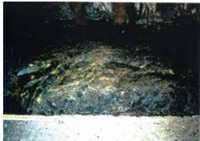
底盤(南側)No.190~191 写真
