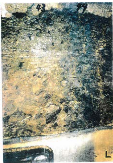
底盤(南側)No.43~44 写真
