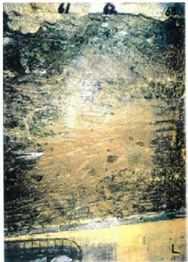
底盤(南側)No.61~63 写真
