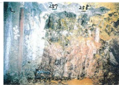
側壁(下半南側)No.257~258 写真
