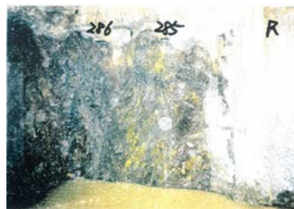
側壁(下半北側)No.286~285 写真
