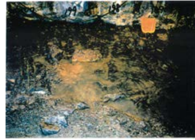
底盤(北側)No.197~200 写真
