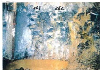
側壁(下半南側)No.261~262 写真
