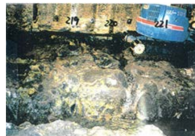
底盤(南側)No.219~221 写真
