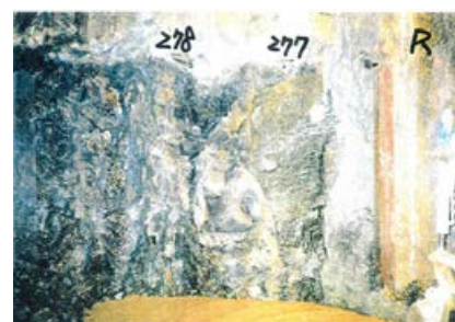
側壁(下半北側)No.277~278 写真
