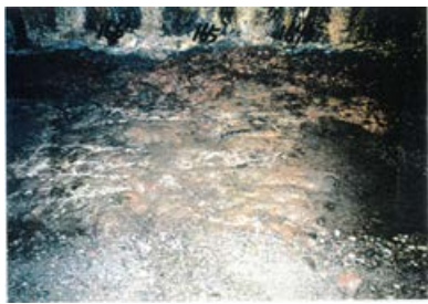
底盤(北側)No.164~166 写真
