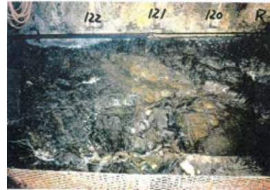
底盤(北側)No.120~122 写真
