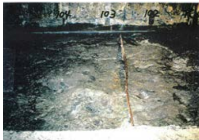
底盤(北側)No.102~104 写真
