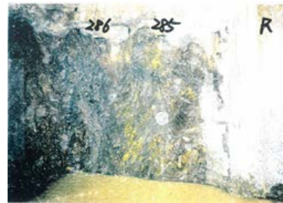
側壁(下半南側)No.285~286 写真
