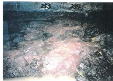
底盤(南側)No.253~254 写真
