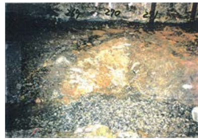
底盤(南側)No.269~271 写真
