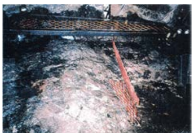
底盤(北側)No.3~5 写真
