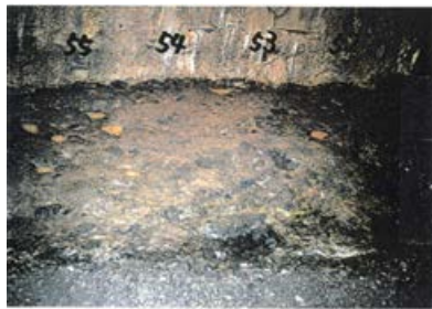
底盤(北側)No.52~55 写真
