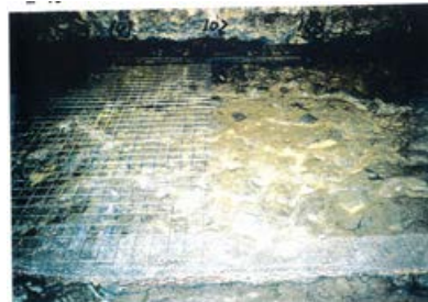
底盤(南側)No.101~103 写真
