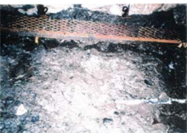
底盤(北側)No.9~10 写真
