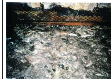
底盤(南側)No.9~10 写真
