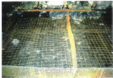
底盤(北側)No.11~13 写真
