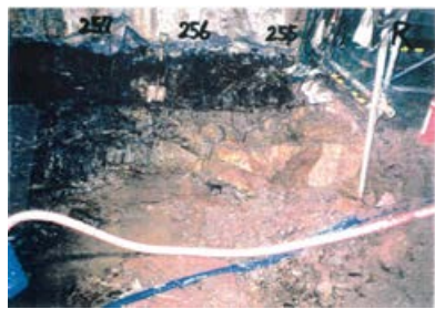
底盤(北側)No.255~257 写真
