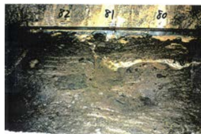
底盤(北側)No.80~82 写真
