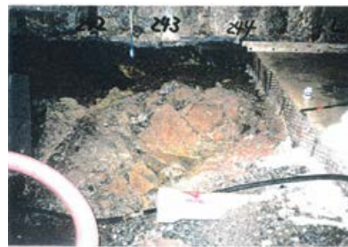
底盤(南側)No.242~244 写真
