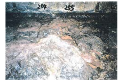
底盤(南側)No.254~255 写真
