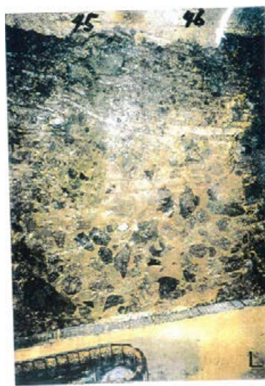
底盤(南側)No.45~46 写真
