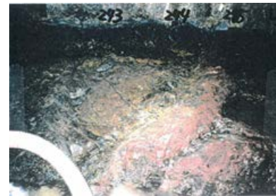
底盤(南側)No.243~245 写真
