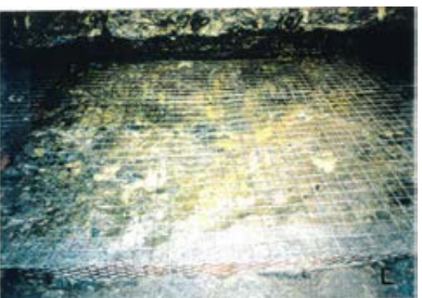
底盤(南側)No.99~101 写真
