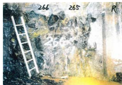
側壁(下半北側)No.265~266 写真
