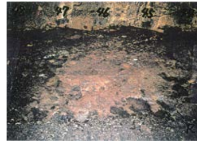
底盤(北側)No.44~48 写真
