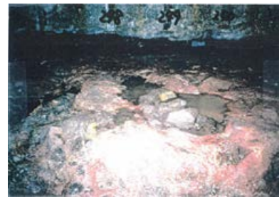
底盤(南側)No.248~249 写真
