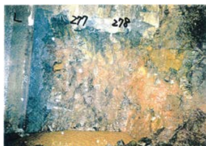
側壁(下半南側)No.277~278 写真
