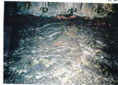
底盤(北側)No.151~154 写真
