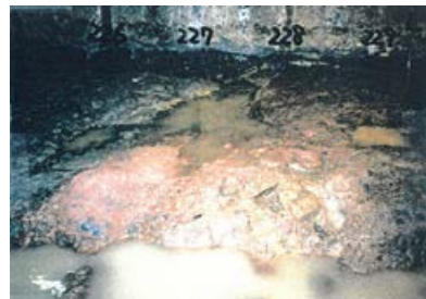
底盤(南側)No.226~229 写真
