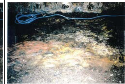
底盤(北側)No.189~191 写真
