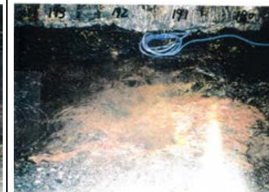
底盤(北側)No.190~193 写真
