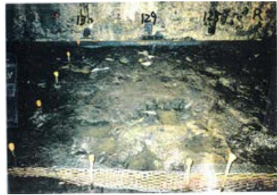
底盤(北側)No.128~130 写真
