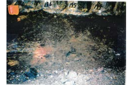
底盤(北側)No.194~196 写真
