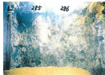
側壁(下半北側)No.285~286 写真
