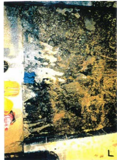
底盤(南側)No.17~19 写真
