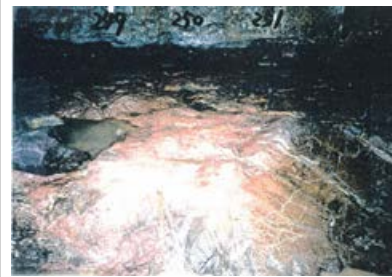
底盤(南側)No.249~251 写真
