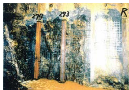
側壁(下半北側)No.273~274 写真
