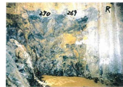
側壁(下半北側)No.269~270 写真
