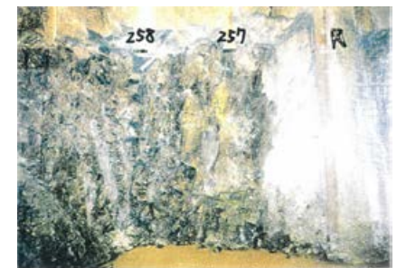
側壁(下半北側)No.257~258 写真
