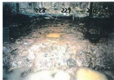
底盤(南側)No.228~230 写真
