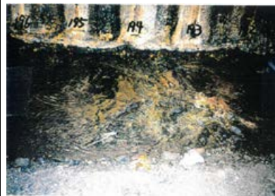
底盤(北側)No.192~196 写真
