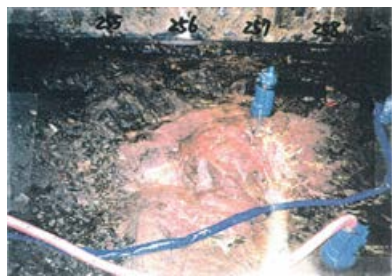
底盤(南側)No.255~258 写真
