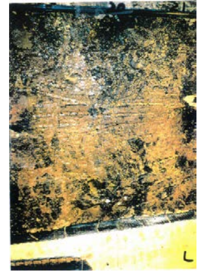
底盤(南側)No.20~21 写真
