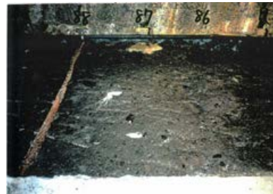
底盤(北側)No.86~88 写真
