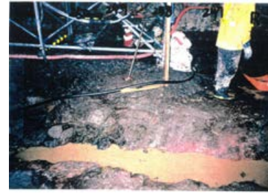
底盤(北側)No.247~250 写真
