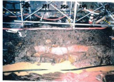
底盤(北側)No.249~252 写真
