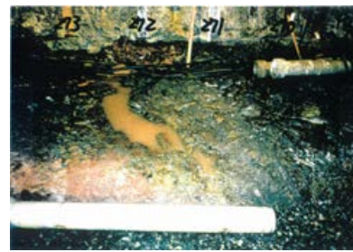
底盤(北側)No.270~273 写真
