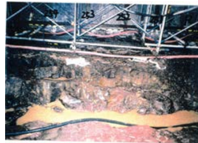
底盤(北側)No.251~254 写真
