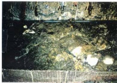
底盤(北側)No.114~116 写真
