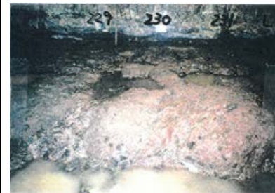
底盤(南側)No.229~231 写真
