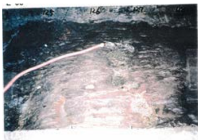
底盤(南側)No.125~127 写真
