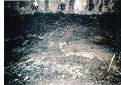
底盤(北側)No.158~160 写真
