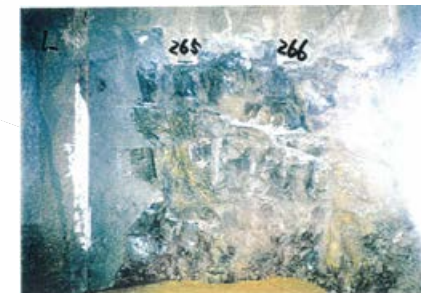
側壁(下半南側)No.265~266 写真
