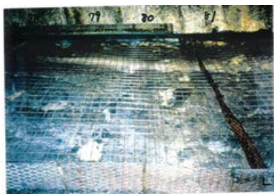
底盤(南側)No.78~81 写真
