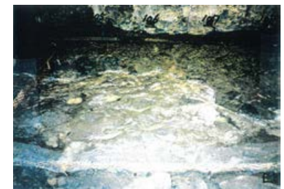
底盤(南側)No.105~107 写真
