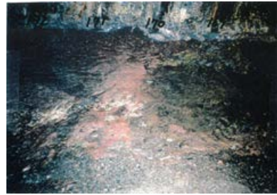
底盤(北側)No.169~172 写真
