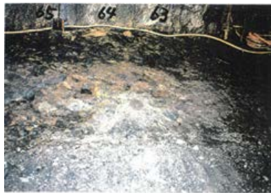
底盤(北側)No.62~65 写真
