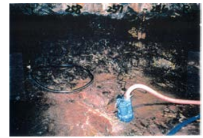
底盤(北側)No.256~258 写真
