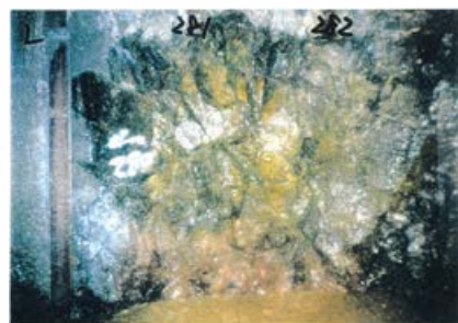
側壁(下半南側)No.281~282 写真
