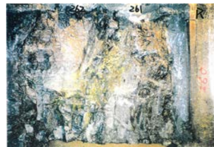
側壁(下半北側)No.261~262 写真
