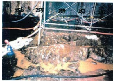
底盤(北側)No.252~256 写真
