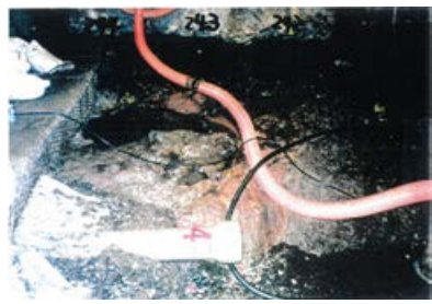
底盤(北側)No.242~244 写真
