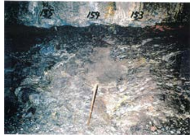
底盤(北側)No.153~155 写真
