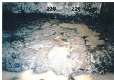
底盤(南側)No.224~225 写真
