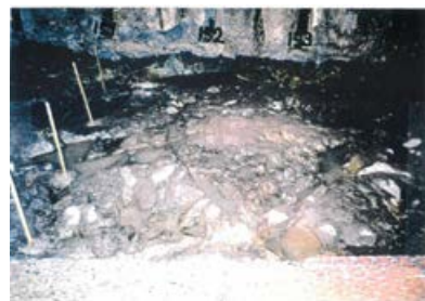
底盤(南側)No.151~153 写真
