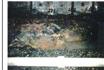
底盤(南側)No.280~283 写真
