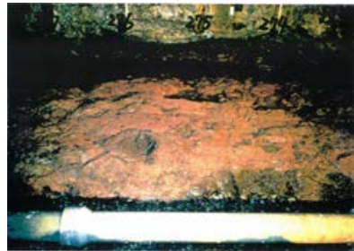
底盤(北側)No.274~277 写真
