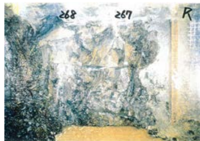
側壁(下半北側)No.267~268 写真
