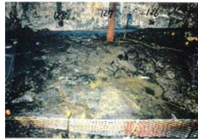
底盤(北側)No.126~128 写真
