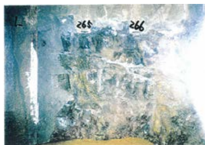
側壁(下半南側)No.265~266 写真
