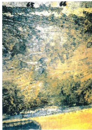
底盤(南側)No.65~66 写真
