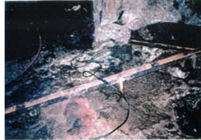
底盤(南側)No.1 写真
