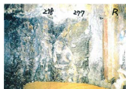
側壁(下半北側)No.277~278 写真
