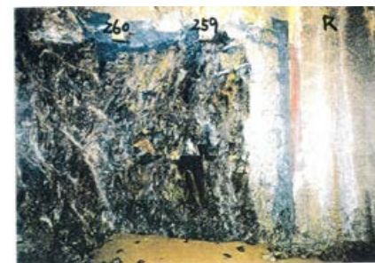
側壁(下半北側)No.259~260 写真
