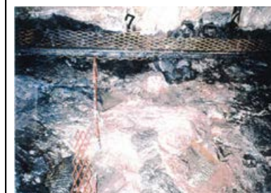
底盤(北側)No.6~7 写真
