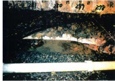
底盤(北側)No.279~281 写真
