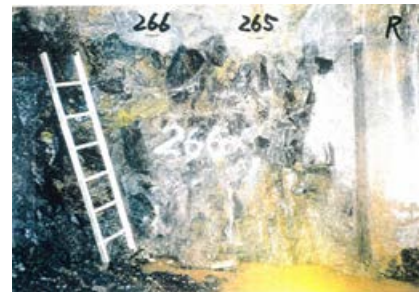
側壁(下半北側)No.265~266 写真
