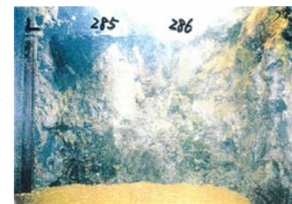
側壁(下半南側)No.285~286 写真
