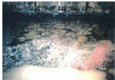
底盤(南側)No.225~227 写真
