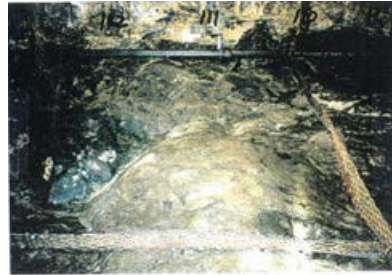
底盤(北側)No.110~112 写真
