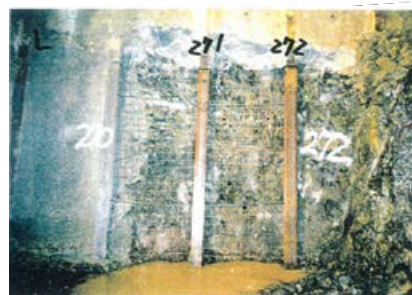
側壁(下半南側)No.271~272 写真
