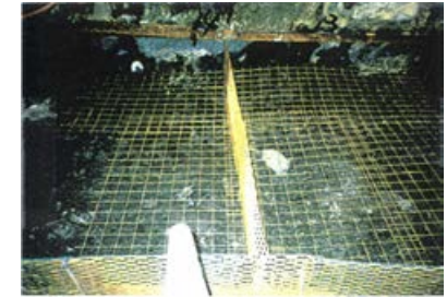
底盤(北側)No.13~14 写真
