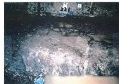
底盤(南側)No.220~222 写真
