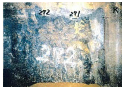
側壁(下半北側)No.271~272 写真
