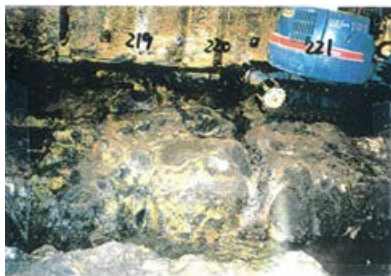
底盤(南側)No.219~221 写真
