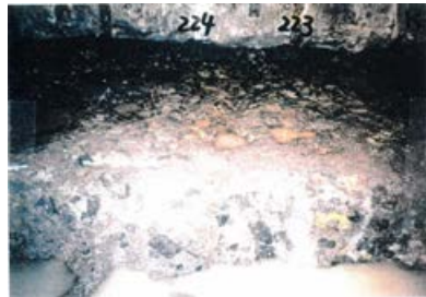
底盤(北側)No.223~224 写真
