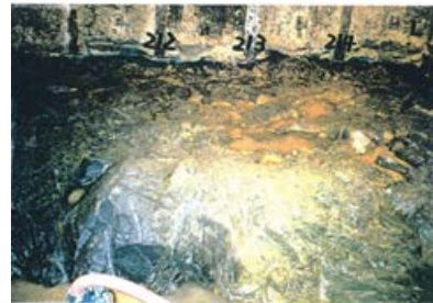
底盤(南側)No.212~214 写真
