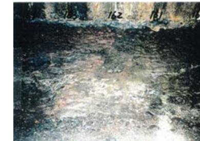
底盤(北側)No.160~163 写真
