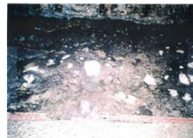
底盤(南側)No.153~155 写真
