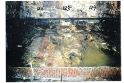
底盤(北側)No.124~126 写真
