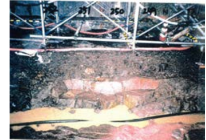
底盤(北側)No.249~252 写真
