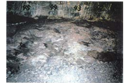
底盤(北側)No.42~45 写真
