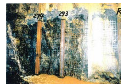
側壁(下半北側)No.273~274 写真
