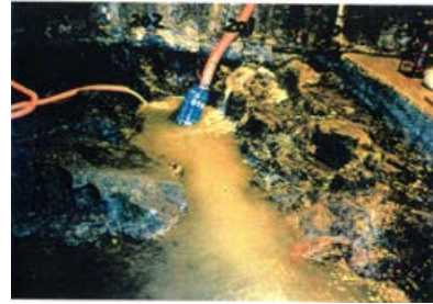
底盤(北側)No.200~202 写真
