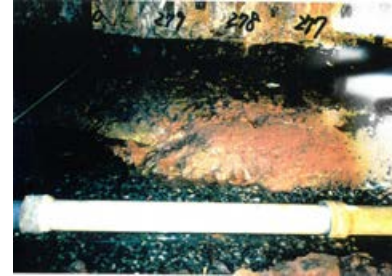
底盤(北側)No.277~280 写真
