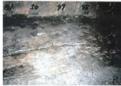
底盤(北側)No.48~51 写真
