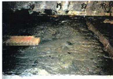
底盤(北側)No.88~90 写真
