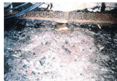
底盤(北側)No.10~11 写真
