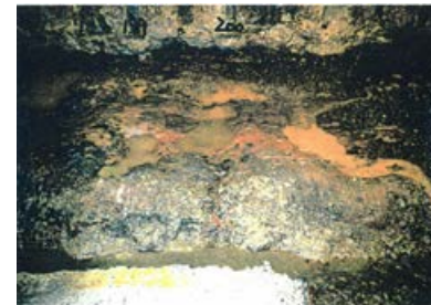
底盤(南側)No.199~200 写真
