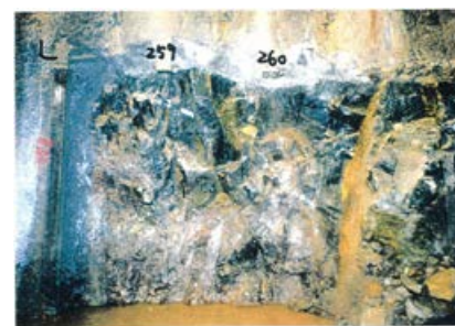
側壁(下半南側)No.259~260 写真
