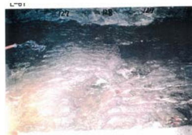
底盤(南側)No.127~129 写真
