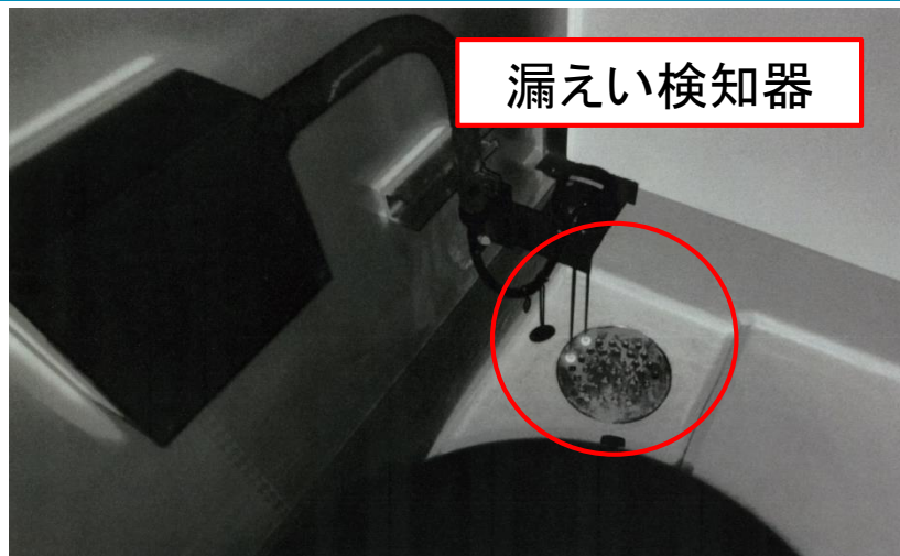
第1図 漏えい検知器 施工例
