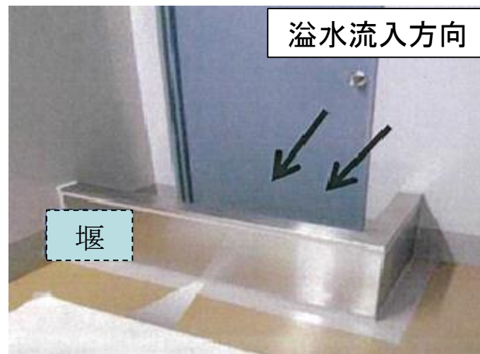
第2-1図 流入防止対策 施工例1
