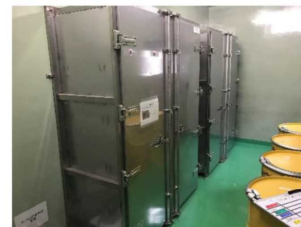
可燃性廃棄物保管庫
