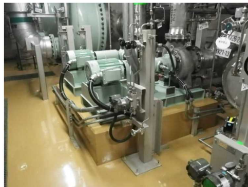
ポンプ基礎のかさ上げ
