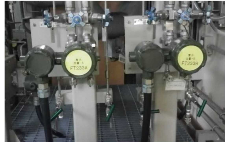
独立した信号及び難燃ケーブルを使用した安全保護系伝送器
