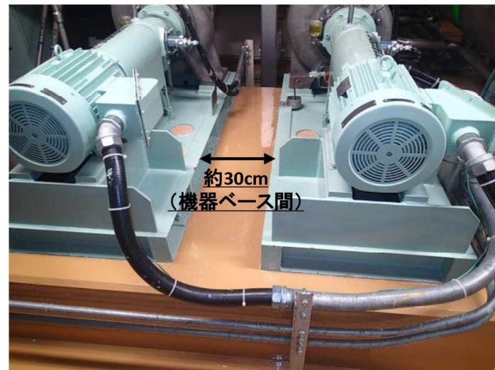
1次冷却材補助ポンプ間分離
