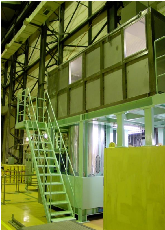
洗浄設備 (外観)
