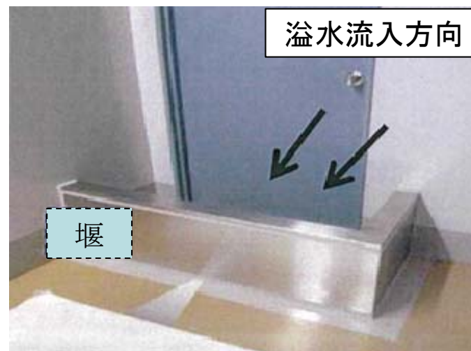
第2-1図 流入防止対策 施工例1
