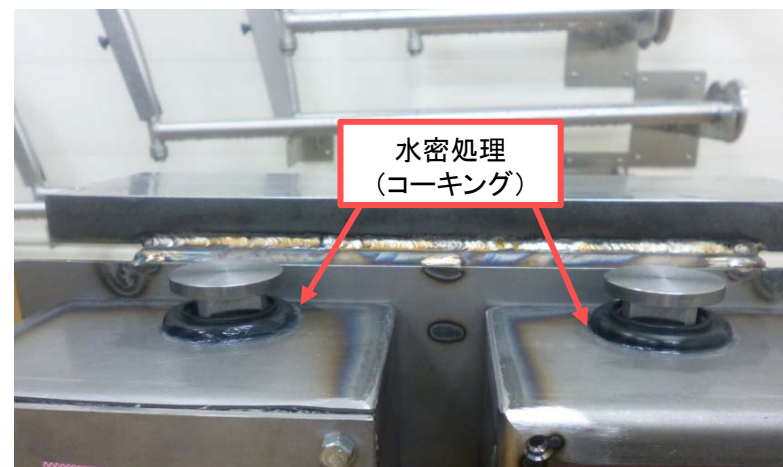
第5図 水密処理 施工例
