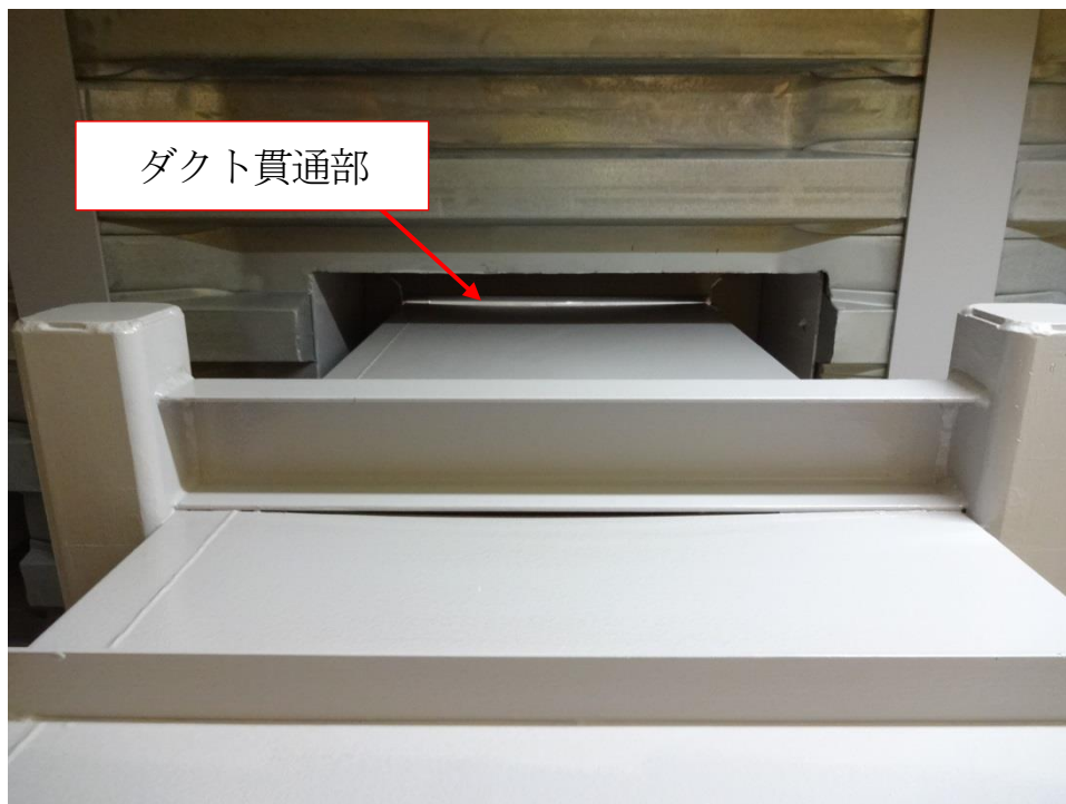
第2図 天井面の貫通部（例）
