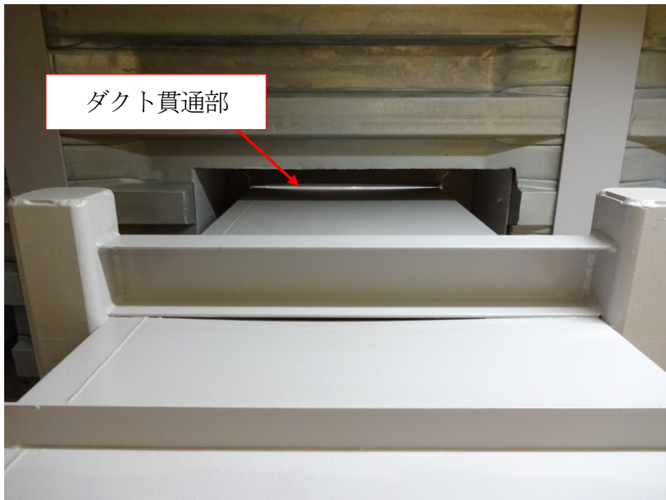
第2図 天井面の貫通部（例）
