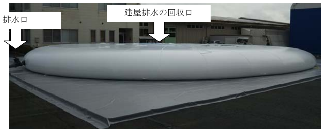
図3 可搬型排水受槽 全景 (イメージ)
