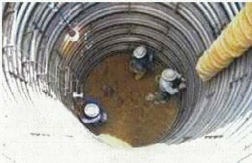
図 5.14.6-3 ライナープレート施工状況
