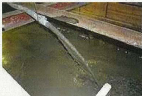
図 5.14.6-7 流動化処理土打設状況
