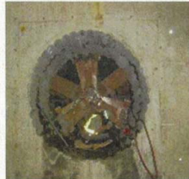
図 5.14.5-4 連続コアによる削孔
