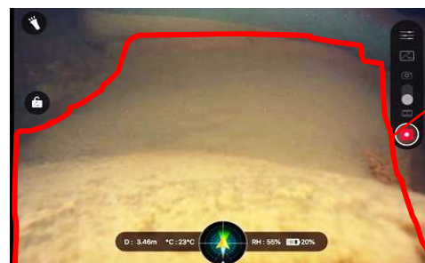
11m付近ROVからの土嚢画像
