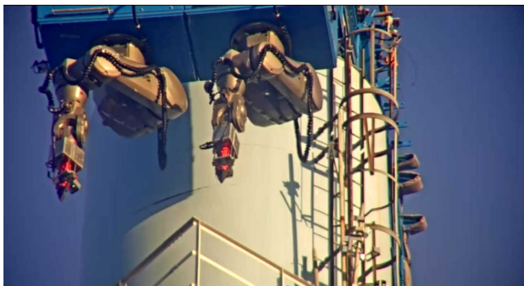
【写真①】筒身切断状況(9月18日)
