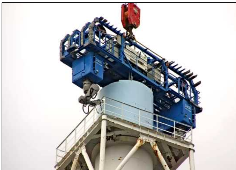
【写真⑤】 切断状況(10月8日)
