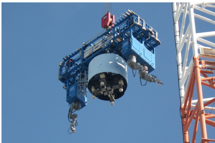
【写真③】吊り下ろし状況(9月26日)
