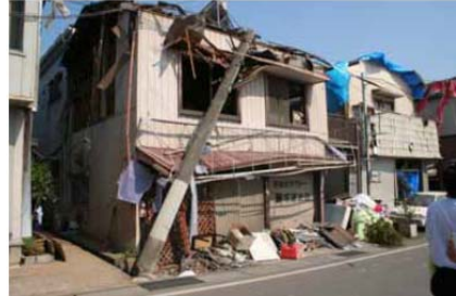
倒壊電柱に直撃された家屋
