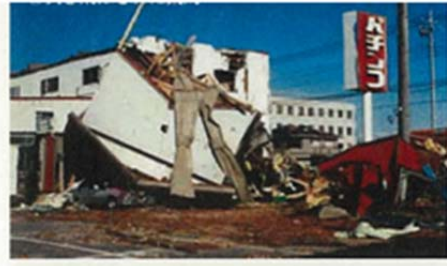
吹き飛ばされた建物
