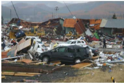
全壊した工事事務所周辺
