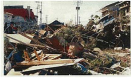
残骸（飛散物）で埋め尽された道路
