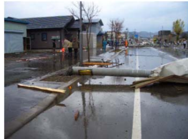
道路側へ倒壊した電柱
