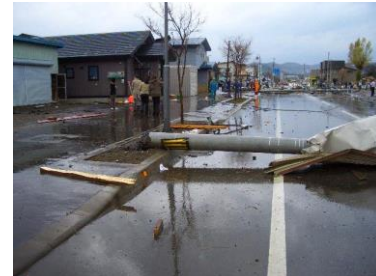
道路側へ倒壊した電柱
