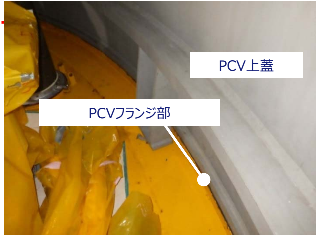
PCV上蓋閉止時 (PCV内から撮影)
