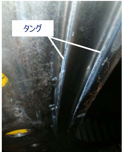
PCV上蓋フランジ部 (※写真 2 号炉。1 号炉も同様のタンガあり)
