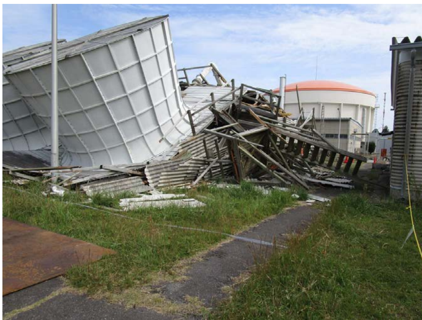
撤去前状況(南側)(令和元年10月7日撮影)
