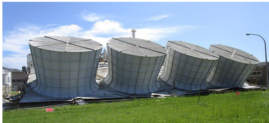
撤去前状況(西側)(令和元年9月12日撮影)
