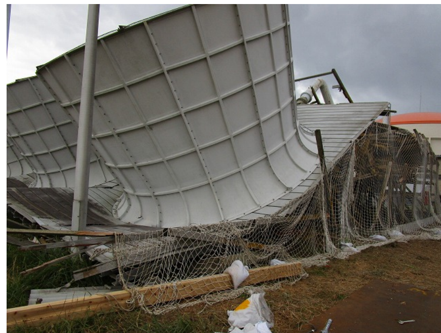
撤去中状況(南側)(令和元年10月24日撮影)
