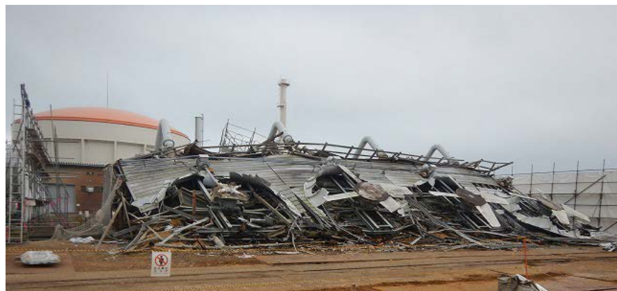
撤去中状況(西側)(令和元年12月11日撮影)
