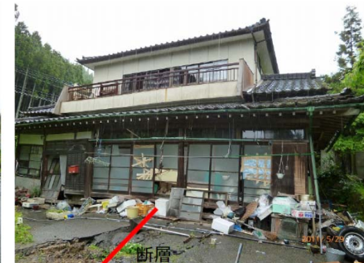
鉄骨造体育館と地表地震断層(D4) 木造建物(D4, 直下の地表断層で傾斜)
