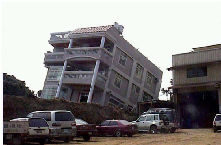
地表断層直上のRC造建物(傾斜による被害) 豊原市中正公園付近の建物
