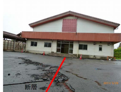
鉄骨造体育館と地表地震断層(D4) 木造建物(D4, 直下の地表断層で傾斜)
