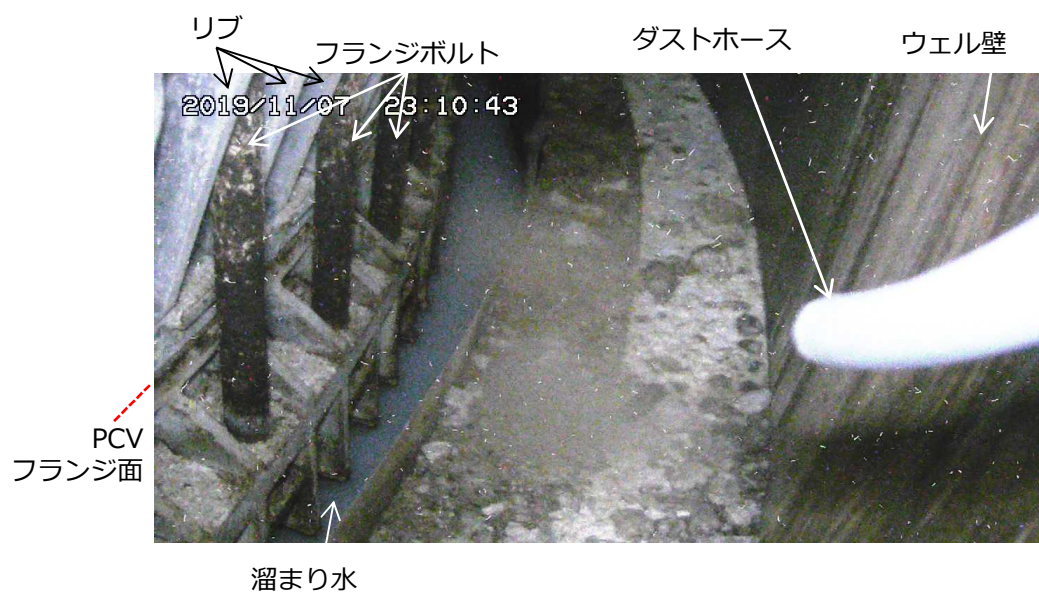
①ダストホース設置状況
