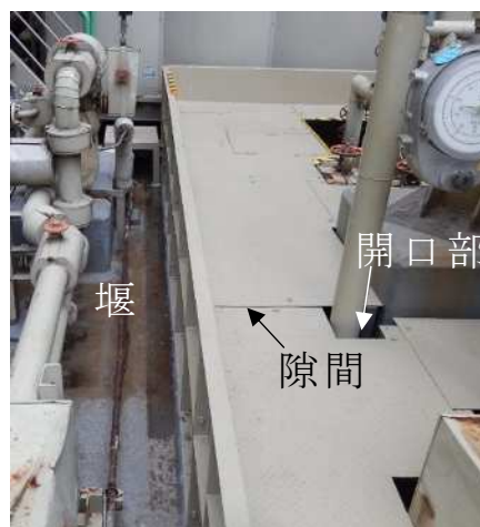
図1 高浜発電所 4号炉 タンク堰への覆い設置状況
